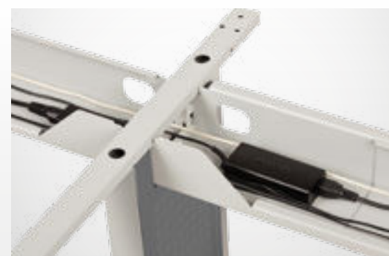
Průběžné vedení kabeláže při řetězení stolů
